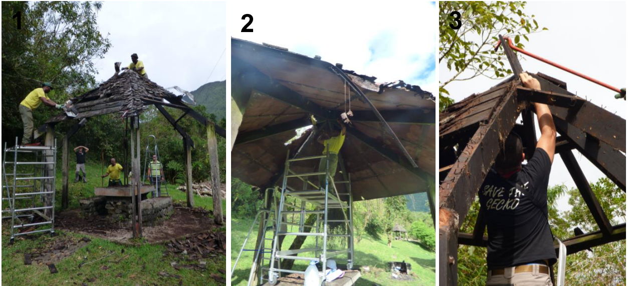
Démontage précautionneux (1&2) et récupération de sauvegarde des œufs (3)
