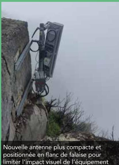
Nouvelle antenne plus compacte et positionnée en flanc de falaise pour limiter l'impact visuel de l'équipement
