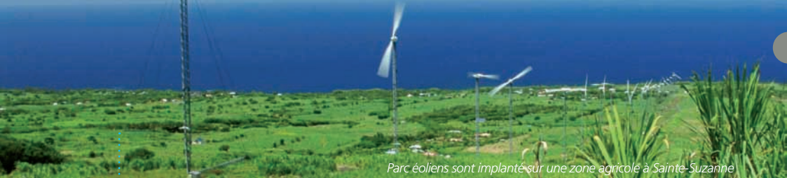
Parc éoliens sont implantés sur une zone agricole à Sainte-Suzanne
